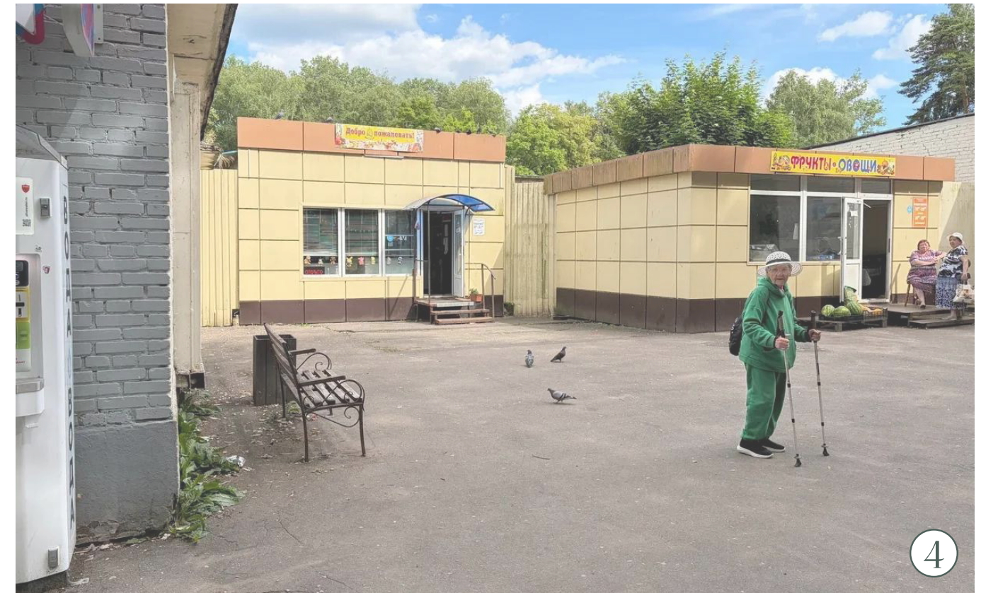
ТРЕБУЕТСЯ ЗАМЕНА МАФ И ОСВЕЩЕНИЯ
